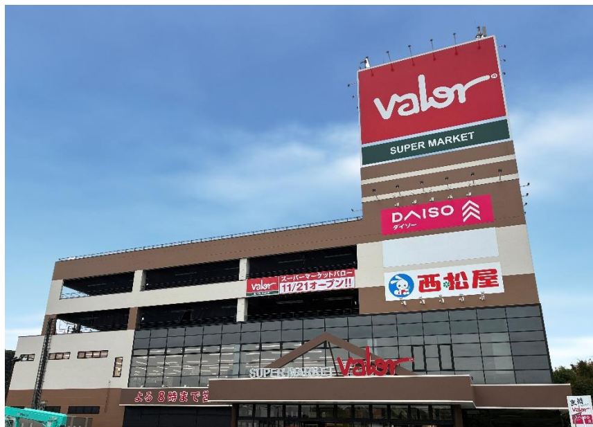
バロー横浜下永谷店外観
